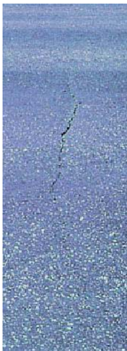
Σχήμα 3.4-1: Διαμήκεις ρωγμές που δεν σχετίζονται με τη διέλευση οχημάτων
