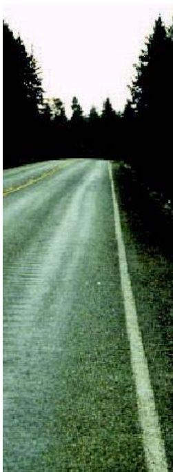
Σχήμα 3.10-1: Εγκάρσια αυλάκωση του οδοστρώματος
