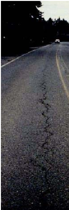
Σχήμα 3.3-1: Διαμήκειες ρωγμές
