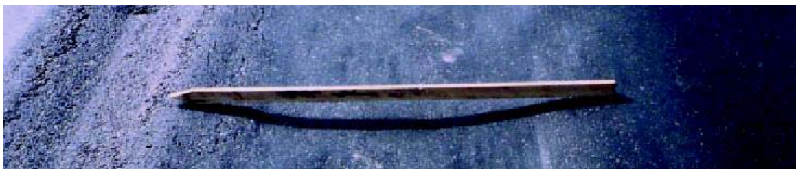
Σχήμα 3.1.1-1: Αυλάκωση του οδοστρώματος
