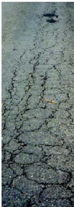
Σχήμα 3.2-1: Ρωγμές τύπου "αλιγάτορα"
