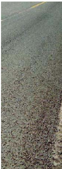
Σχήμα 3.6-1: Αποκόλληση αδρανών από το οδόστρωμα
