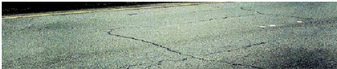
Σχήμα 3.12-1: Ρηγμάτωση του οδοστρώματος κατά τεμάχια
