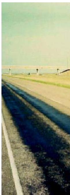
Σχήμα 3.7-1: Εκχείλιση / Εφίδρωση οδοστρώματος
