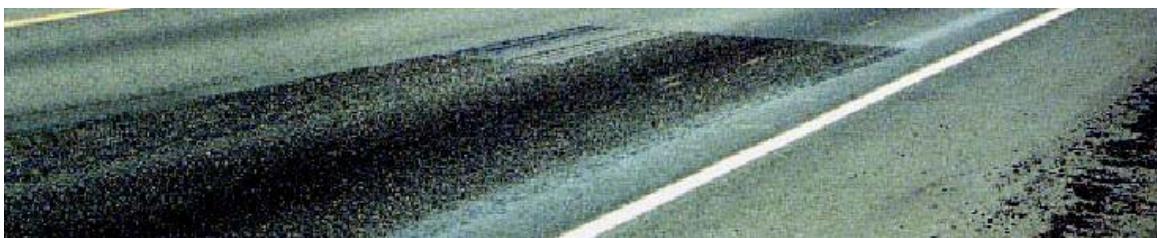
Σχήμα 3.9-1: Τοπική επισκευή του οδοστρώματος
